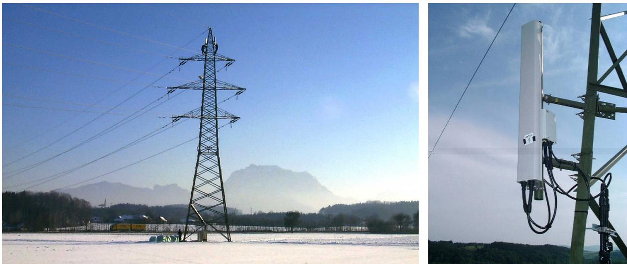
Bild 1: Mobilfunk-Antennen auf einem 110 kV Hochspannungsmast
